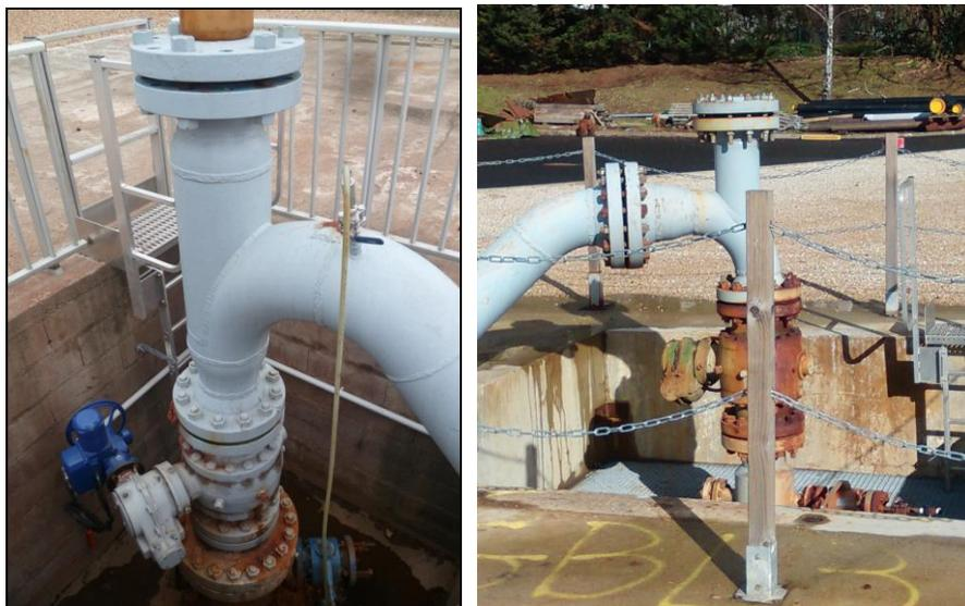
**Figure 62 : Implantation des têtes de puits GBL-1ST et GBL-3 sur le site de la centrale géothermique de Bonneuil-Sur-Marne**
